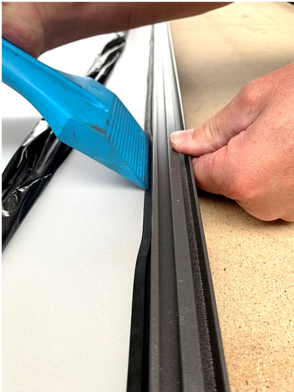
9. Alternativ kann ein Hilfsmittel zur Montage verwendet werden
