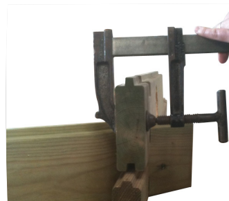
Redirected board • Tabla redirigida • Madrier redressé • neu ausgerichtetes Brett • Tavola riposizionata • Rechtgebogen plank • Tábua redirigida
